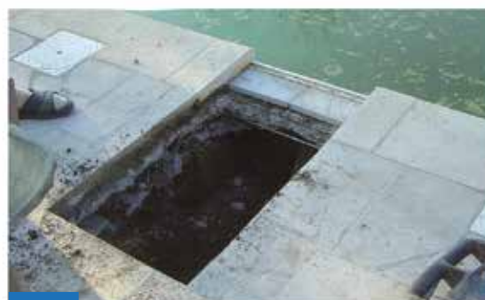
6 Fin des gros travaux
